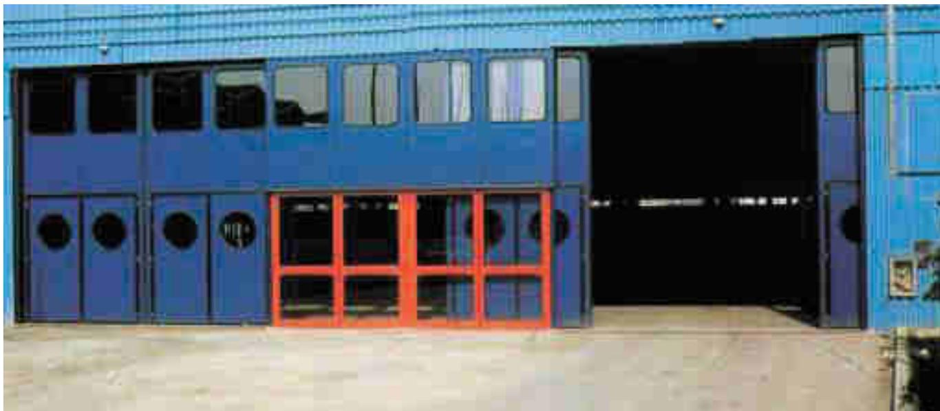
DELTOR FDP a 4 ante (2 + 2) manuali montati su complesso fieristico, porte pedonali di sicurezza senza inciampo inferiore con maniglioni antipanico. Serramenti rossi in funzione di passaggio visitatori, uscita di sicurezza, con maniglioni antipanico (FO).
