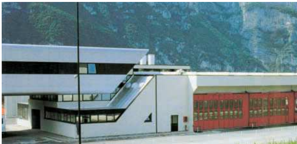
DELTOR FLP a 10 ante 5 + 5 motorizzati colore rosso (centro servizi ferrovia Trento Malè TN)
